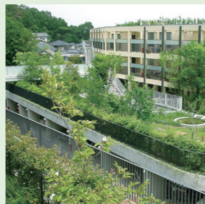
屋上緑化システム
