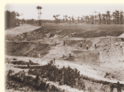
人力で造成されている18番ホール
