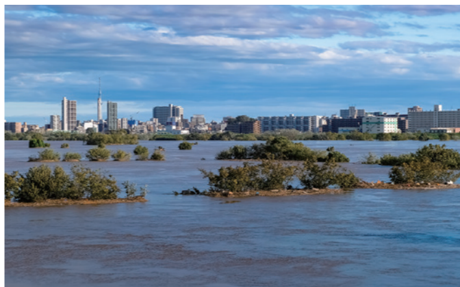
2019年10月 台風19号による荒川の増水(埼玉県戸田市・東京都板橋区・北区)
