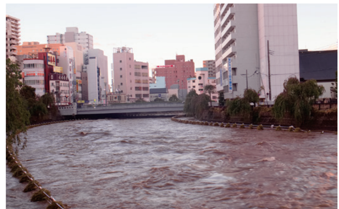
2019年10月 台風19号による田川の増水(栃木県宇都宮市)
